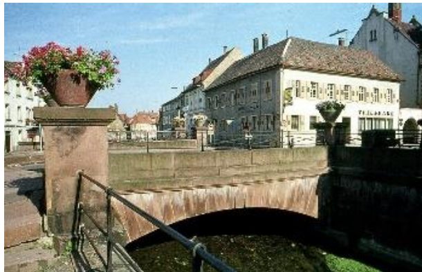
Marktbrücke in Weingarten. Erbaut 1823 unter Leitung von Johann Gottfried Tulla.
